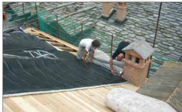
Castello rinnovato - Regione PIEMONTE Isolamento dall'esterno con TRISO-LAINE+.
